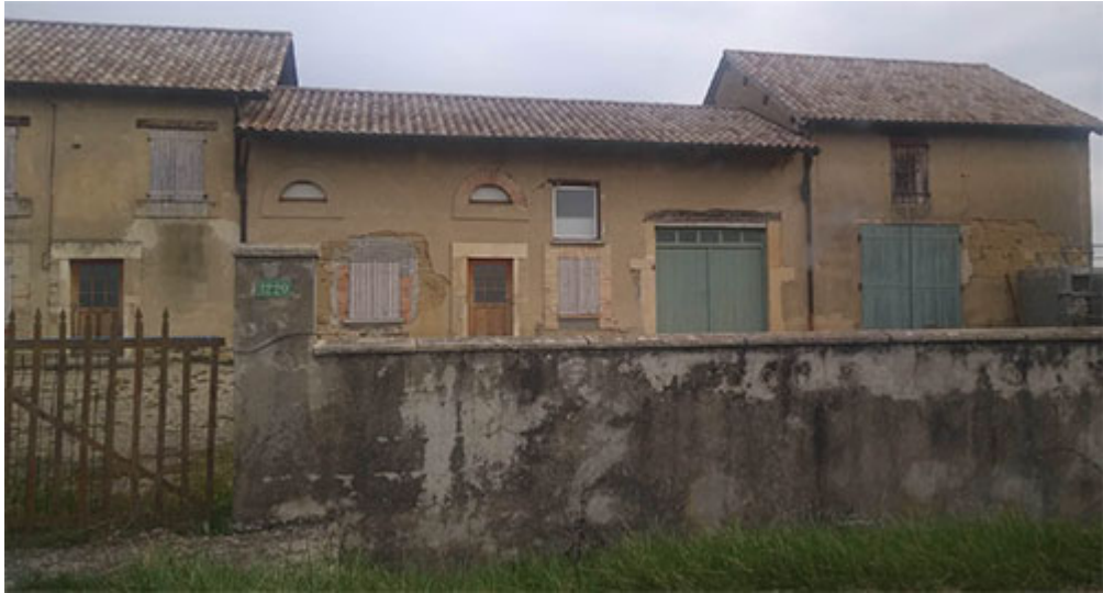
Construction en pisé, route de Pizay
