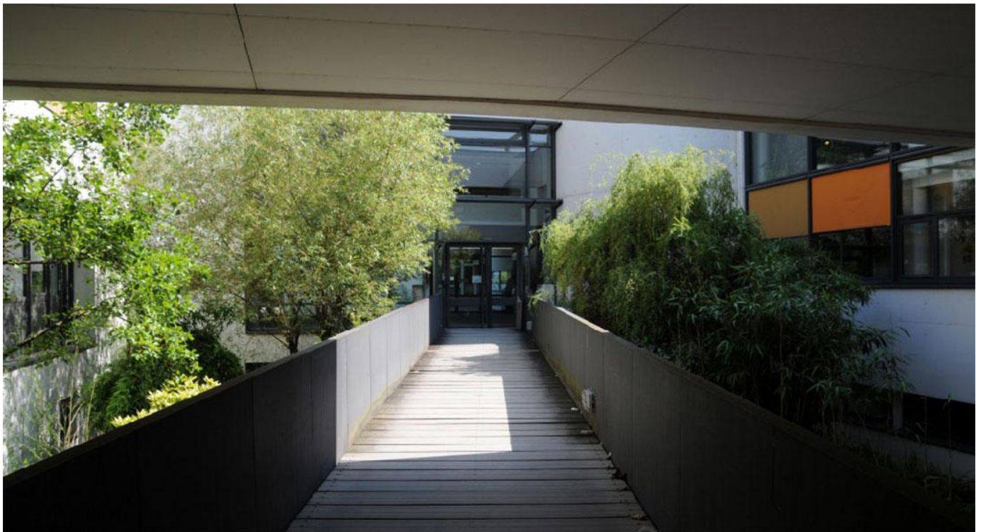
Passerelle de l'entrée secondaire du bâtiment de l'ENTPE
