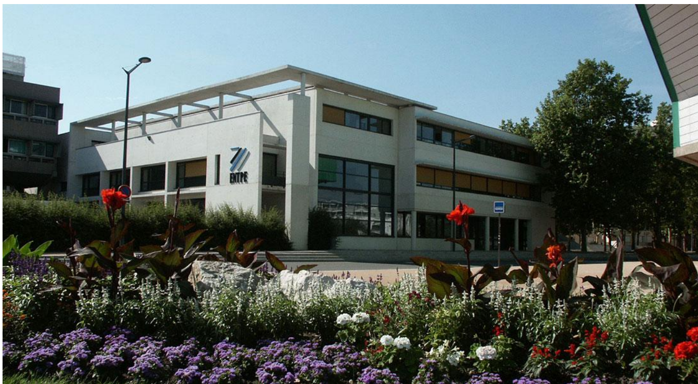
Bâtiment principal de l'ENTPE
